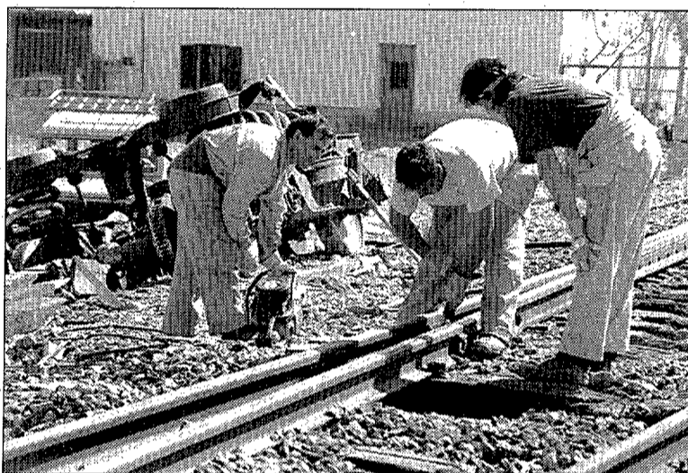
Hoy proseguirán las labores para arreglar las vías.
